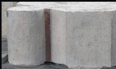
Éléments sculptés à la gradine et bretteuse fine utilisée perpendiculairement Taille parallèle
