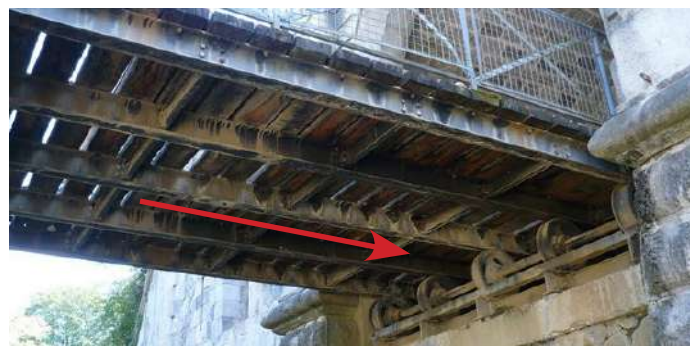
Fig 32 : Photo pont à effacement longitudinal du fort de Feyzin
