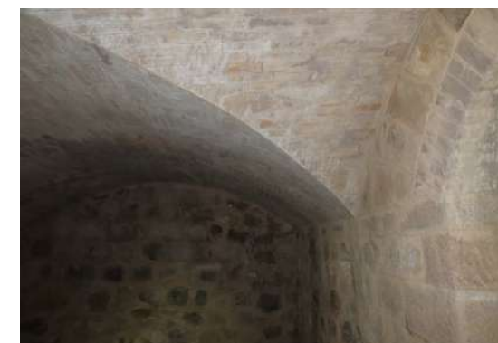
Fig 52: Photo intérieur de la caponnière simple Sud-Est
