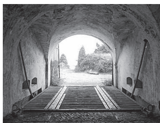
Fig 37: Photo système Ardagt : Fort de du Mont Chauve de Tourette
