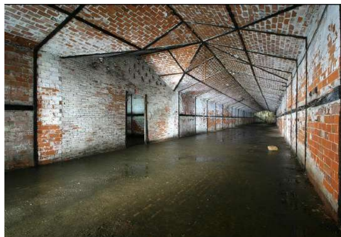
Fig 9: Aménagement d'assainissement du fort du mont Voudois_Structure en brique rapporté sous la voûte en pierre
