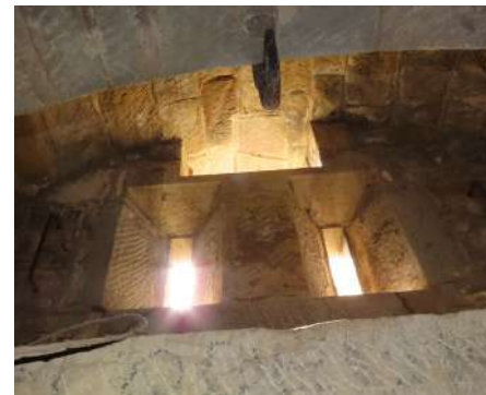
Fig 45: Photo ouverture d'aération caponnière Simple Sud-Est
