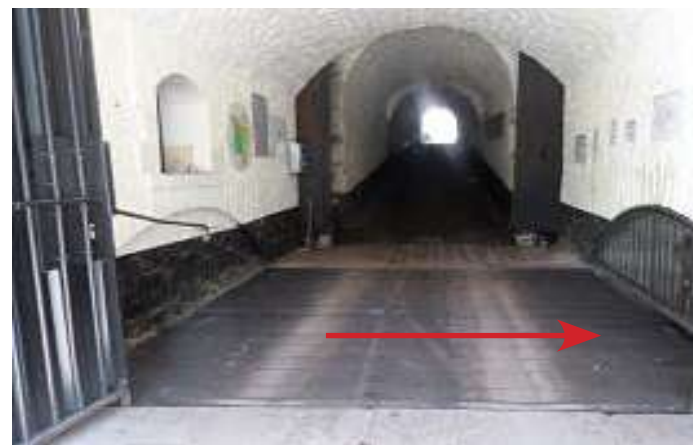
Fig 31: Photo pont à effacement latéral du fort de Parmont
