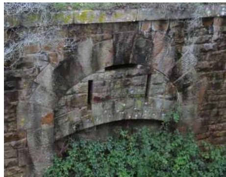
Fig 44: Photo ouverture caponnière simple Sud-Est, ouverture d'aération
