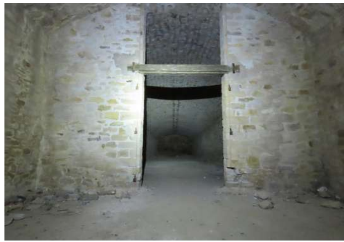
Fig 20: Photo chambre souterraine.
