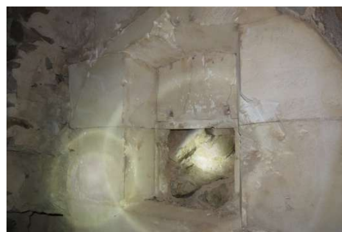
Fig 60: Photo ouverture chambre des lampes comblés
