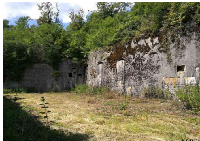
Fig 7: Photo du coffre de la batterie de l'Eperon
