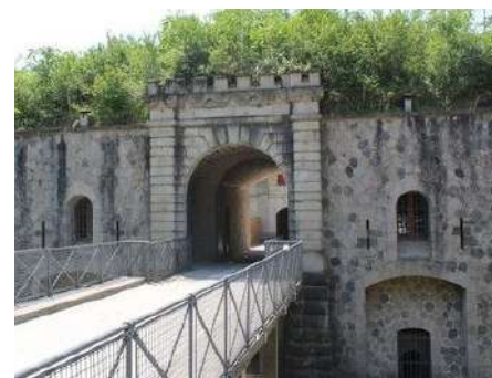
Fig 48: Photo porte d'entrée du fort de Feyzin, fenêtres latérales
