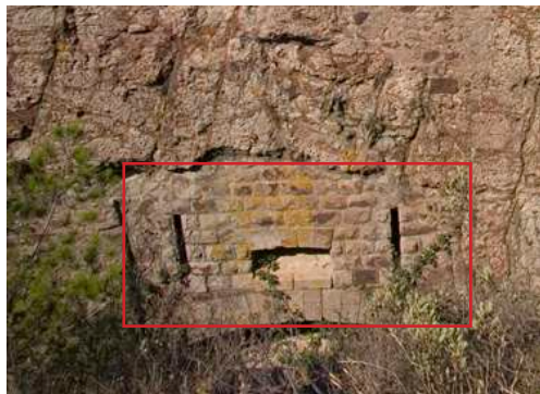
Fig 43: Photo ouverture caponnière double, créneau de fusillade
