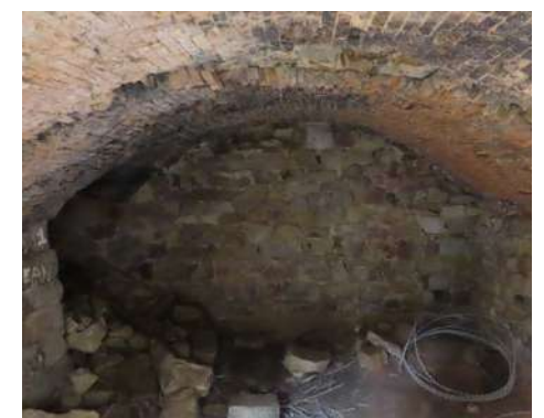
Fig 54: Photo intérieur de la caponnière simple Sud-Ouest
