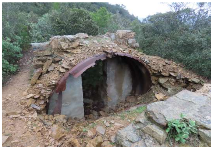
Fig 10: Photo abris annexe avec structure en tôle
